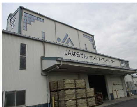
カントリーエレベーター
